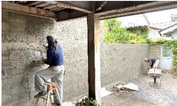
ブロック塀の修繕工事に腕をふるう左官職人さん。暑い中、もっと熱い気持ちでひと塗りひと塗り真剣に向き合っています。その結果が一つ一つの現場の素晴らしい仕上がりに繋がっているのです。マツモト工務店はチームワークをいつも大事にしています。
