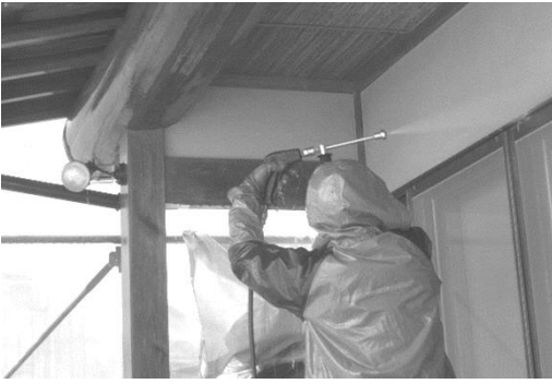
3月の見学会で職人が高圧洗浄の実演をしている様子です。
