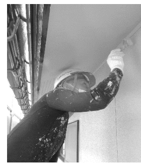
塗装作業中の職人
