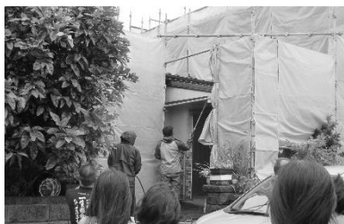
施工中の現場で、高圧洗浄を見学。施工中のお家と塗替え完了後のお家とを回りました。
