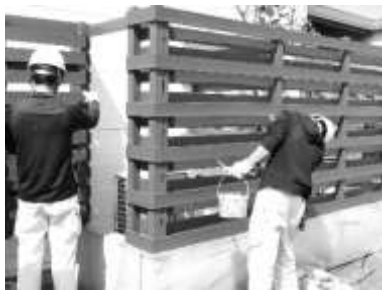
目隠し木フェンスの塗装
